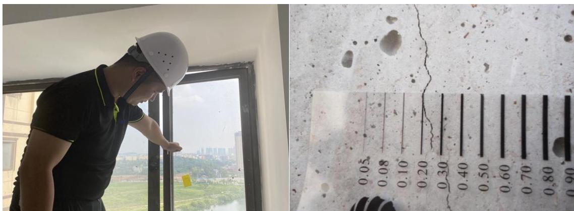
2、核心技术指标：检查距离通常不超过手臂长度（约 0.7 米）。敲击检查需使用重量约 250g 的检查小锤。
